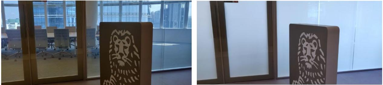
O ponto chave do design é a possibilidade de conectar os espaços com design e tecnologia. Quando a privacidade é necessária, basta 0,1 segundo para tornar a parede de vidro opaca.
