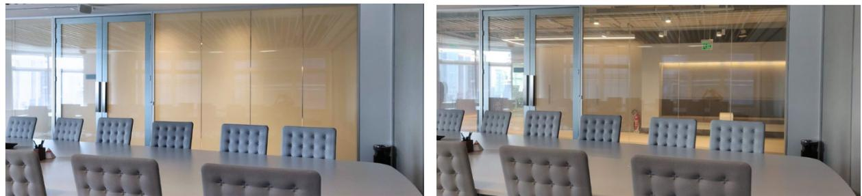
O **vidro inteligente Intelliglass** pode ser especificado em diferentes tamanhos e formatos. Permite ser integrado ao sistema de automação do banco como também pode ser ativado por controle remoto, temporizadores ou sensores.
