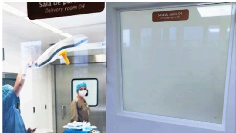
O vidro inteligente Intelliglass é capaz de bloquear até 50% da luz visível, quando necessário, proporcionando total privacidade aos pacientes e conforto aos cirurgiões. A ativação do vidro ocorre através de uma pequena corrente elétrica e a transição de transparente para opaco de maneira instantânea. O vidro também oferece proteção contra raios UV, bloqueando até 99% dos raios UV.
